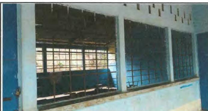
Foto 4: Instalación de ventanas de metal para mayor seguridad del establecimiento, debido al deterioro de los mismos.
