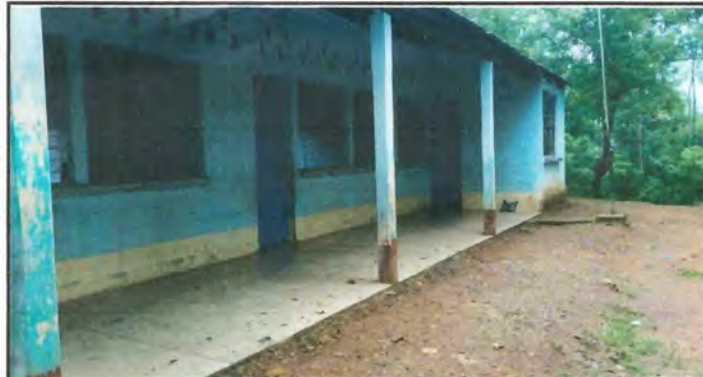
Foto1: Pintura en paredes tanto en interior como exterior del establecimiento educativo.
