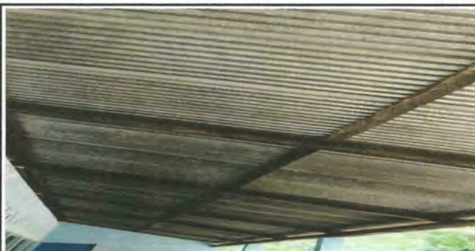
Foto 6: Instalación de estructura metálica debido al deterioro de la madera.
