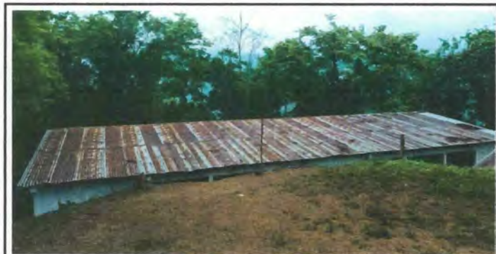
Foto 5: Instalación de lámina troquelada en aulas del establecimiento, debido al deterioro de las laminas acanaladas.
