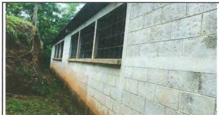
Foto 3: Instalación de balcones de metal debido al deterioro de los mismos.
